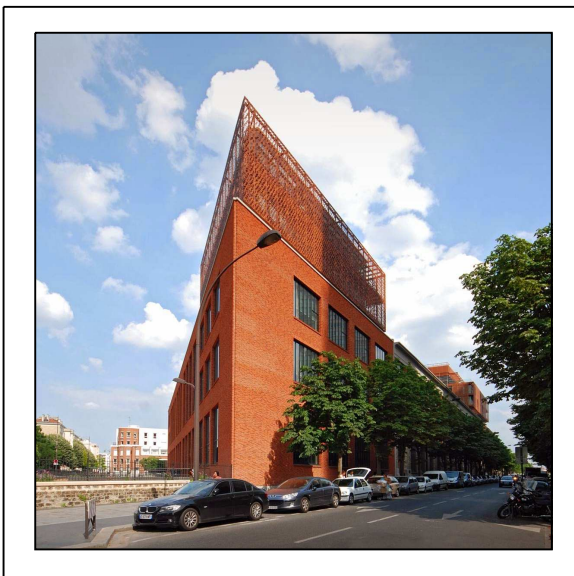
La pointe du triangle après réhabilitation (doc AREP).
